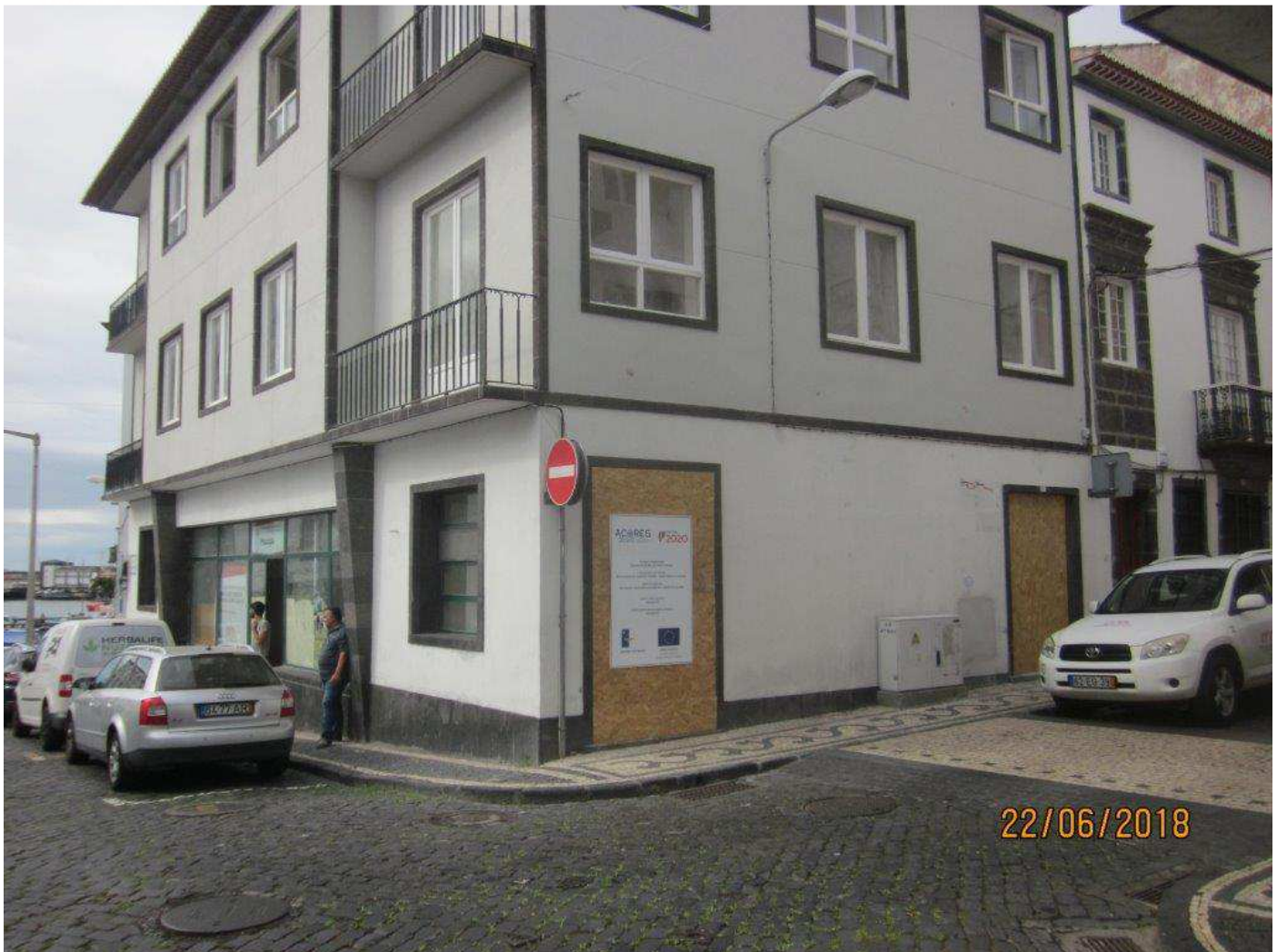
Edifício da rua da Cruz - enquadramento
