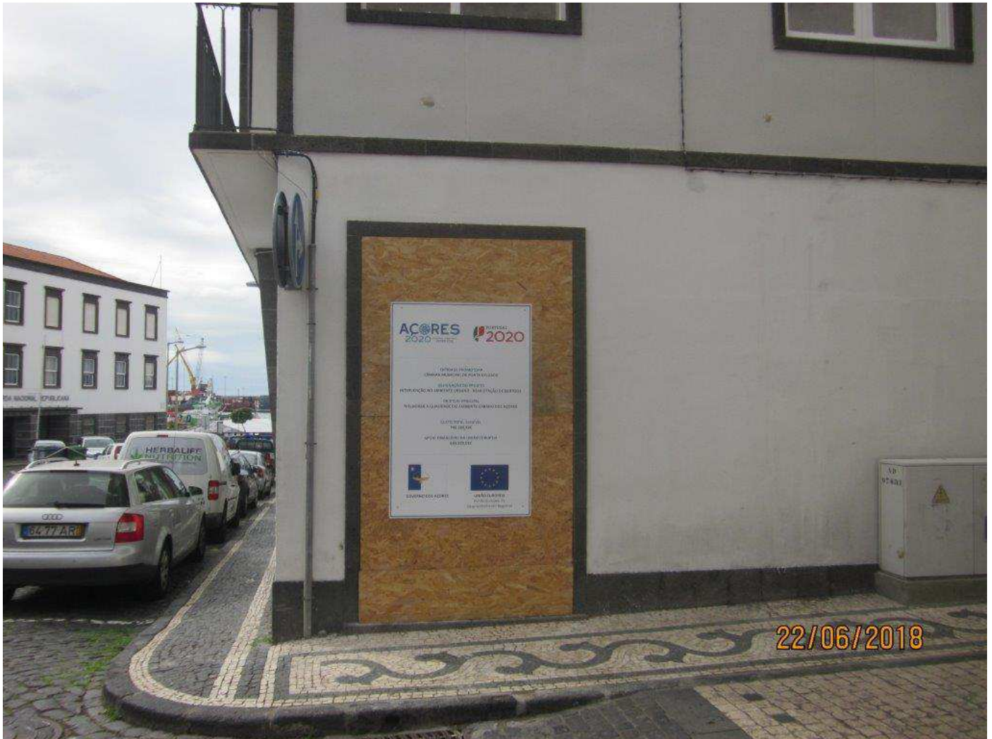
Edifício da rua da Cruz - pormenor
